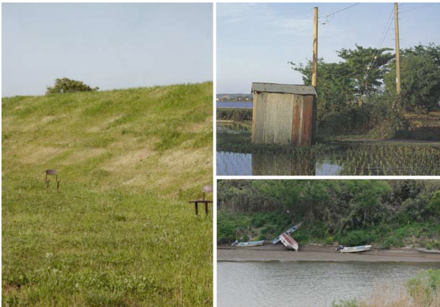
土手に放置された小学校の椅子 (左) ポンプ小屋 (右上) 船 (右下)
