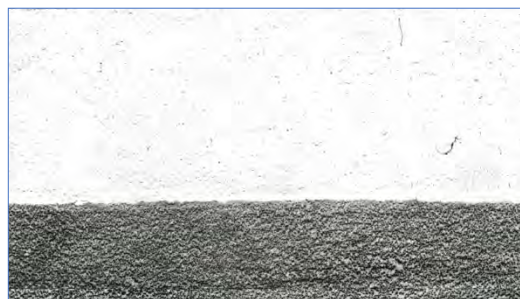
図 6 : cut36 補修された横断歩道
